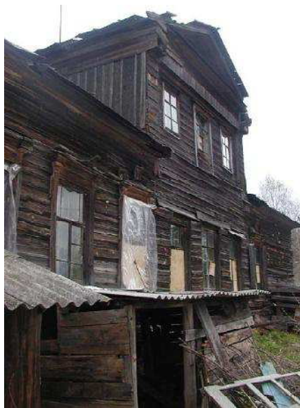
Рис. 6. Дом Лобисов. Современное состояние
